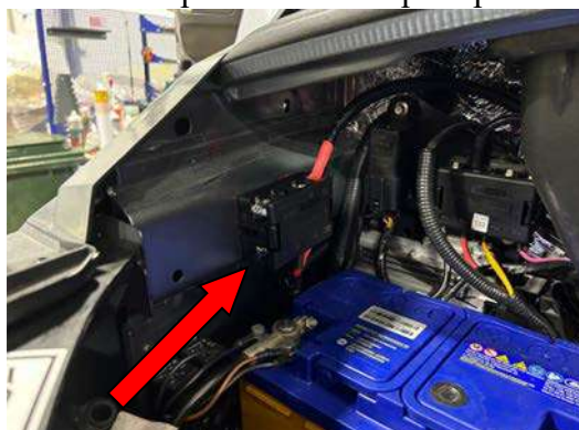
Рисунок 4 – Блок предохранителей под капотом справа вблизи штатной аккумуляторной батареи (АКБ) автомобиля
